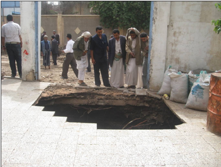
حفرة انهدامية في مدينة الاصبحي (الامانة) داخل فناء احد المنازل
